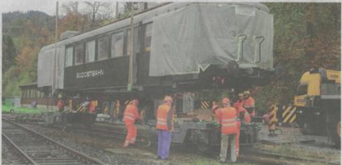
Der historische Triebwagen wird auf die beiden Drehgestelle aufgesetzt.
