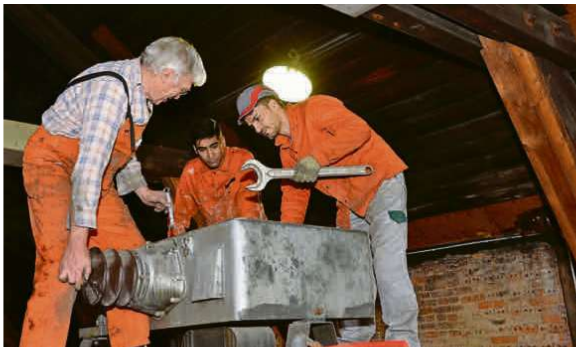
Robert Graf zerlegt mit Hilfe von Hamid Reza Hosseini und Zakarya Parvizi (von links) den Hauptschalter auf dem Dach des Triebwagens. Bild: Urs Weisskopf
