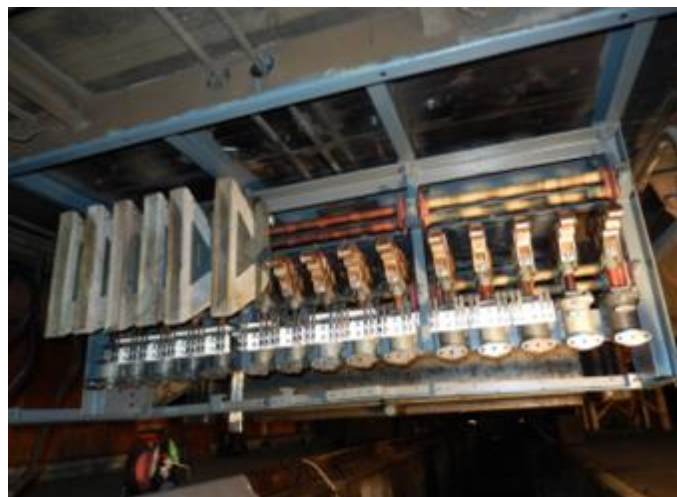
Die Hüpfunterteile mit den Zylindern sind alle montiert, ebenso die ersten 6 Oberteile.
